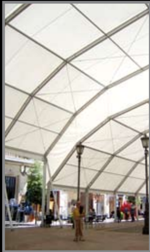
Carpas poligonales de 20 mts. de pórtico y diferentes alturas unidas mediante canalón de lona para el Ayuntamiento de Borja (Zaragoza).
